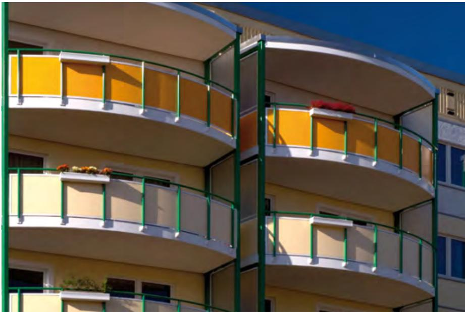
Les profilés d'encadrement du haut et du bas (2 mm d'épaisseur) doivent être cintrés. Seules des fixations linaires glissantes sont autorisées (pas de fixations ponctuelles). Les extrémités droites du côté des aboutements entre panneaux Exterior doivent également être encadrés (profilé en U, profilé en H).
